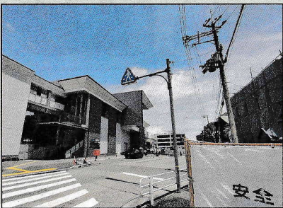
駅舎の改修と共に 住宅等の解体も始まった再開発エリア
