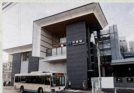
3月26日より JR芦屋駅南口の供用が始まりました
