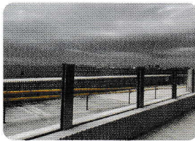
アクリル板設置箇所
